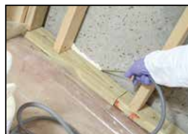
Mueva la varilla hacia la posición de abierto y dispense.
